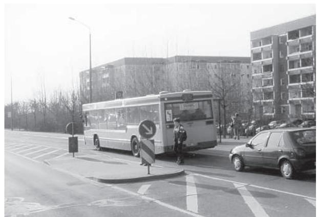
**Abbildung 7** Die Mittelinsel an dieser Kaphaltestelle verhindert das gefährliche Überholen des Busses während des Fahrgastwechsels.
