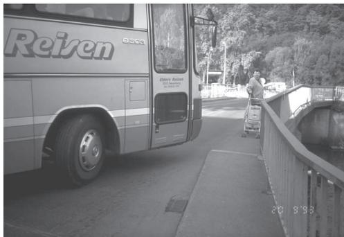
**Abbildung 1** Schmale Gehwege ohne Sicherheitsraum führen zu gefährlichen Situationen
