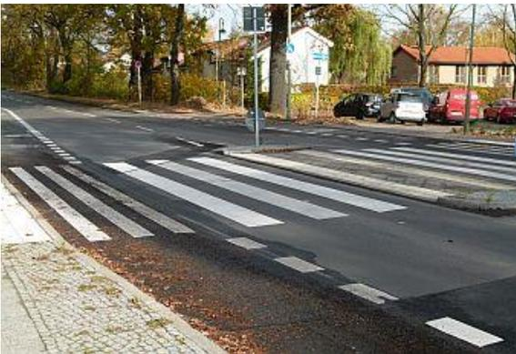
3. Um diese in der Mitte geführte Querung zu unterstützen, wird empfohlen, die Markierungen des FGÜ auch über die Radwege hinweg zu führen, so wie es in der R-FGÜ Zebrastrifen ebenfalls empfohlen wird (3.3 Abs. 4). Dies kann durch 0,25 m breite Streifen mit 0,25 m breiten Zwischenräumen erfolgen, wie es z.B. im Berliner Einführungserlass zur R-FGÜ festgelegt wurde (5. Zu 3.3 Abs. 4).
