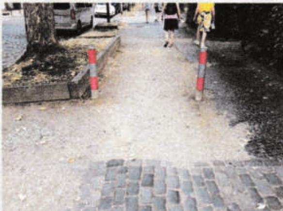
Über die halbe Gehwegbreite ist der schöne (etvl. denkmalgeschützte?) Kleinpflasterbelag entfernt worden. Der noch vorhandene Belag ist ausgefrant und birgt an den kanten Stolpergefahr. Die Nutzung mit Rollhilfen, Kinderwägen etc. ist mühsam. Der Bürgersteig ist so abgepollert, dass hier kein Auto auf dem „zu breiten“ Gehweg parken kann. Die Poller sind nicht die schönsten☹.
