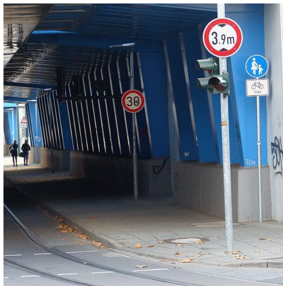
Bahnunterführung Bahnhofstraße zum Dresdener Platz
